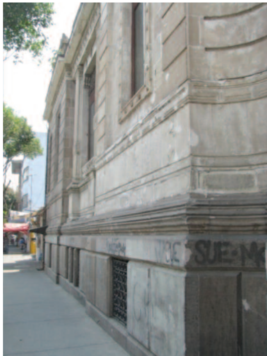
El edificio se desplantó un poco más de dos metros de altura para colocar un sótano con ventilas al exterior, y así evitar humedades.
