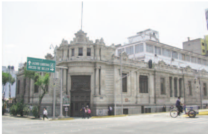
Perspectiva del edificio del Instituto Médico Nacional después de las obras del metrobús.
