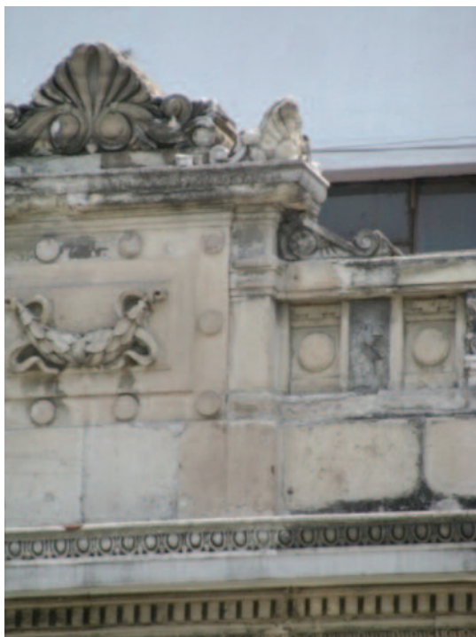
Los pretiles tenían la función de otorgar proporción al edificio, además de ocultar los niveles que se producen por las bajadas de aguas pluviales.
