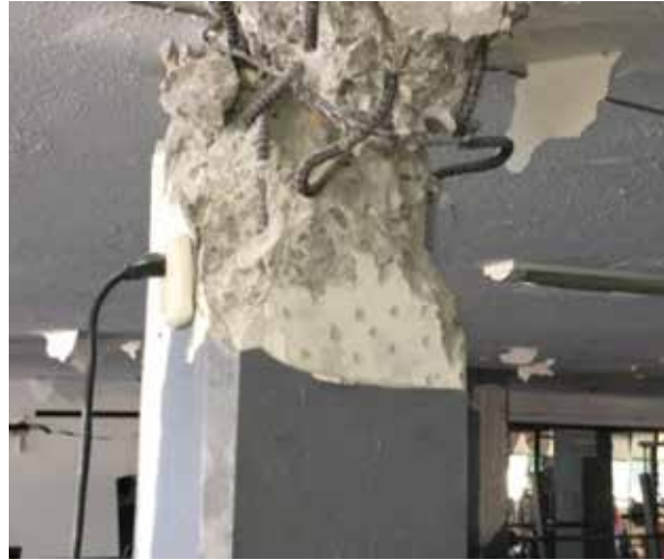
Figura 2. Las construcciones diseñadas de acuerdo con reglamentos antiguos deben revisarse y, en su caso, reforzarse.
