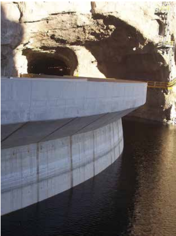
Figura 2. Presa hidroeléctrica de Zimapán. La construcción de grandes obras de ingeniería puede devastar el ambiente; esta presa cubrió la mitad de un cañón y puso en riesgo a las biznagas.
